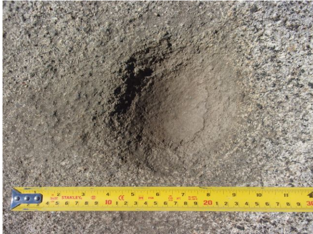
Photograph 19. MMJC-1 mortar detail (Oblique)
